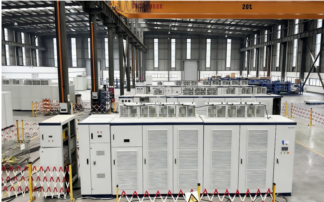
啸驰电气 10000m 2 变频生产基地——制造车间一角
